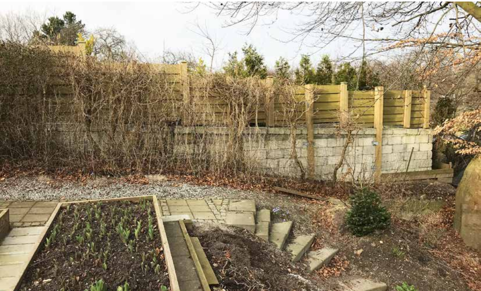
Naboens støttemur. I Københavns kommune må man kun hæve terrænet med 30 cm i skelbræmmen.
